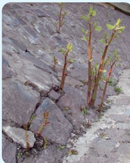
Abb. 16: Nach Hochwasser 2002 errichtete neue Ufermauer an der Weißeritz, Aufnahme Mai 2006
